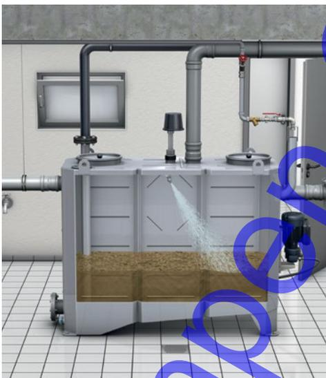
Hochdruckinnenreinigung bei einem Fettabscheider zur rückstandsfreien Entsorgung
